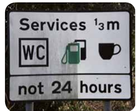
Efecto de Activa en media señal de tráfico, tras varios años a la intemperie.
